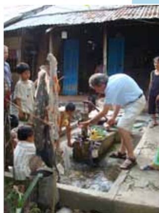
BASAID-Hilfe beim Brunnenbau
