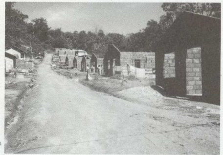
Häuser im Rohbau.
